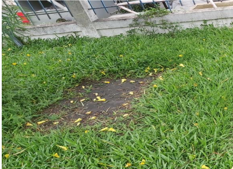
Hình 3.2. Hố ga đầu nối nước thải KCN Amata
